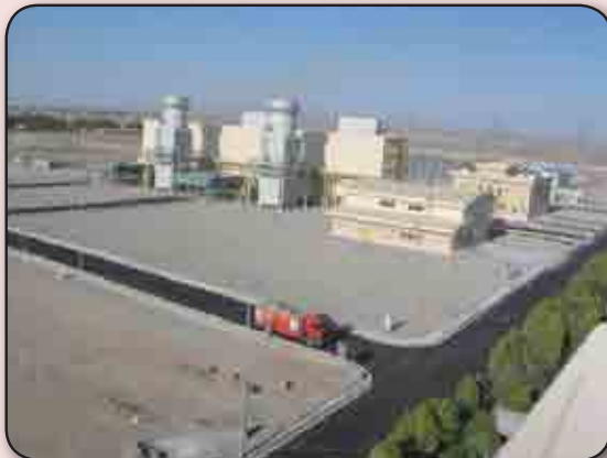
نمایی از نیروگاه گازی ایرانشهر
