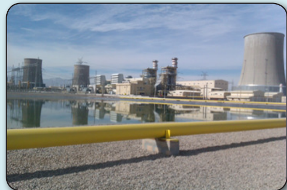
نمایی از نیروگاه سیکل ترکیبی شیرکوه
