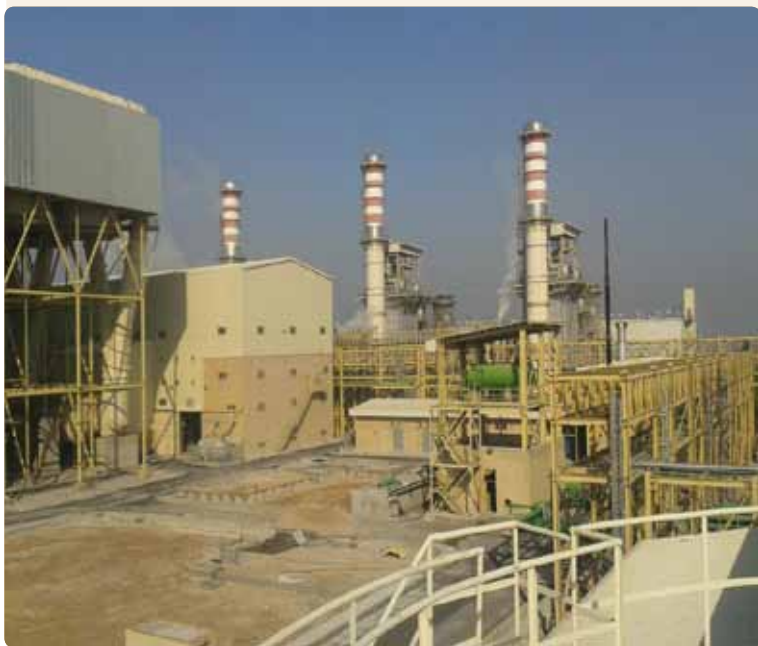
نمایی از نیروگاه سیکل ترکیبی آبادان
