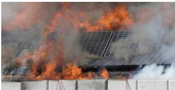
شکل ۲: آتش‌سوزی در یک نیروگاه فتولتائیک
