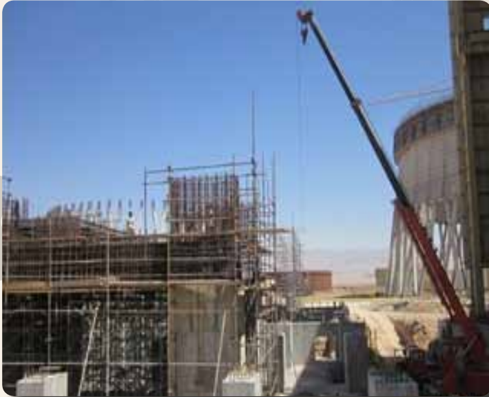
آرماتور بندی و قالب بندی Top Deck واحد دوم
