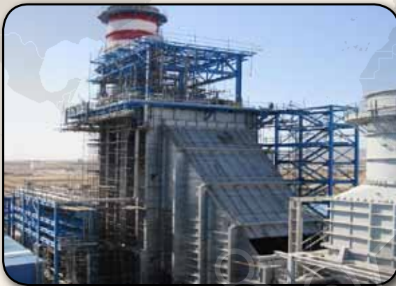
ادامه عملیات لوله کشی اینترنال - ادامه عملیات لوله کشی اکسترنال-1-HRSG
