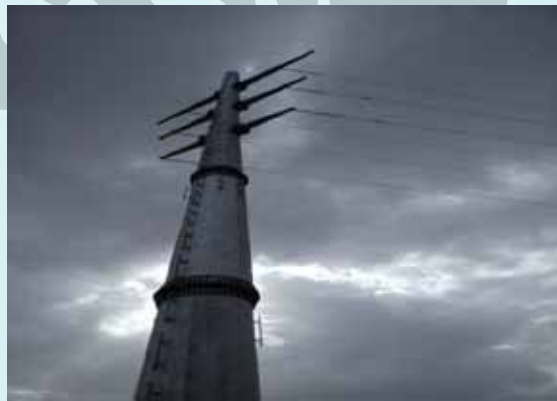
برج چهار مداره ۱۳۲ کیلوولت K۴B۶۰ بعنوان ترمینال
