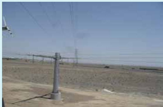
برج دومداره تلسکوپی OTYC-۳۰ جهت عبور از زیر خط موجود
