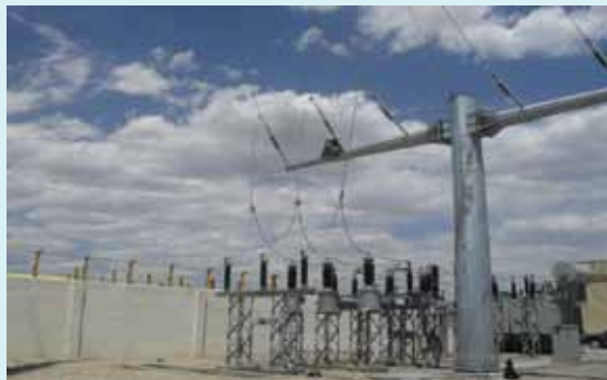
برج دومداره تلسکوپی OTYC-۳۰ بعنوان گنتری
