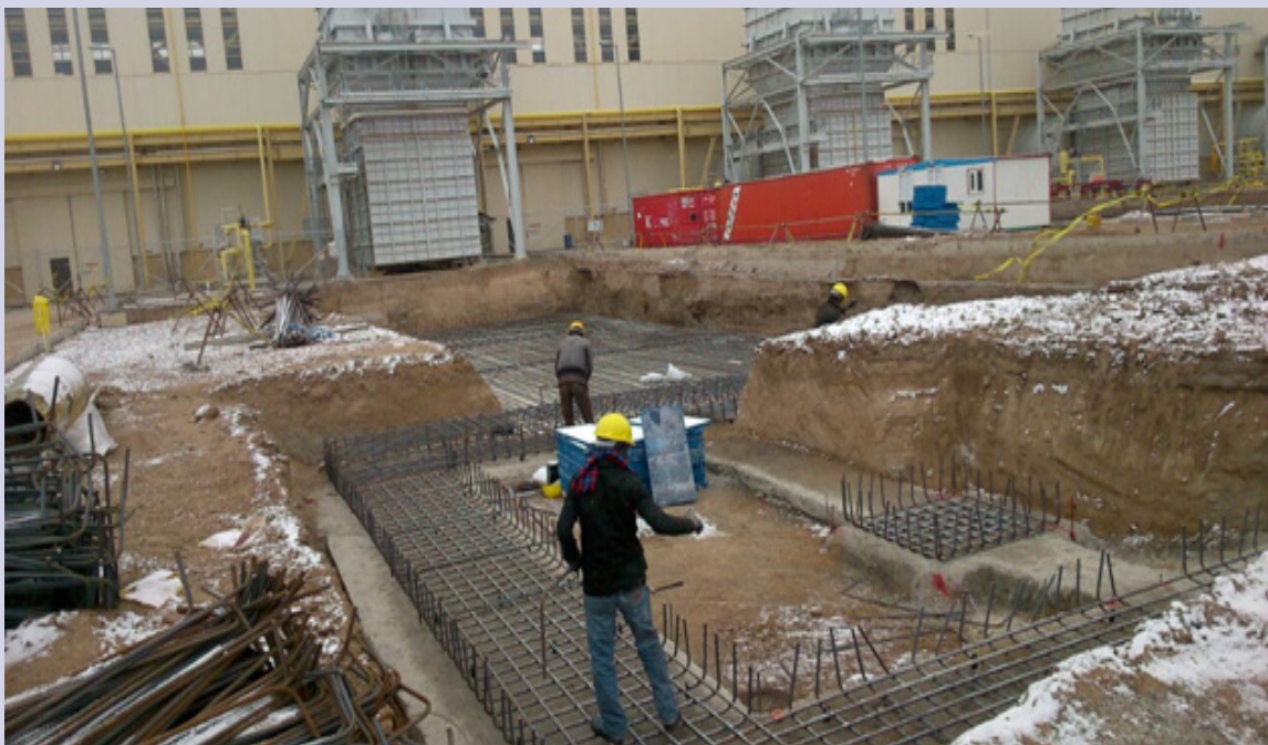
نمایی از عملیات آرماتوربندی محدوده HRSG نیروگاه سیکل ترکیبی سبلان
