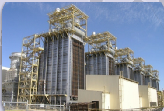
نمایی از نیروگاه سیکل ترکیبی جهرم
