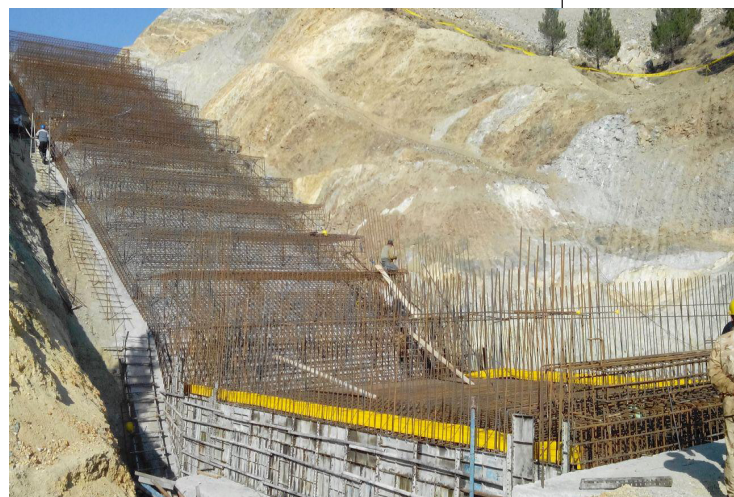
عملیات ساخت حوضچه آرامش و سرریز پلکانی
