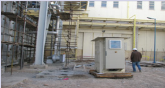
نصب هیدرولیک یونیت دایورتر ۳
