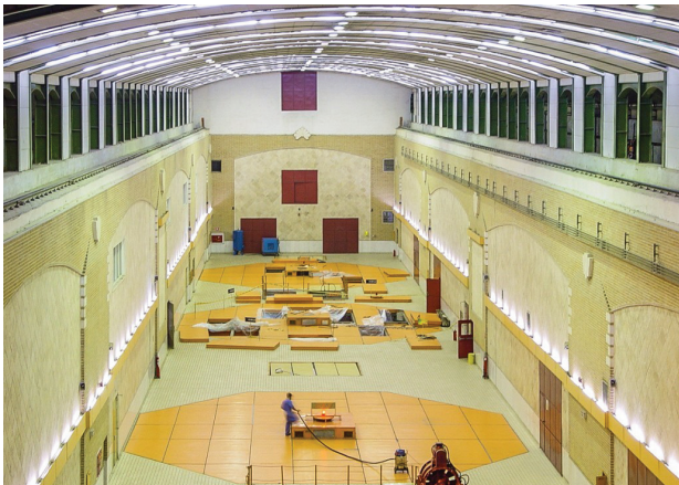
۴- نمایی از نیروگاه آبی
