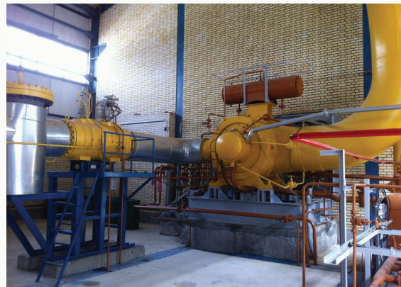
توربین انبساطی نصب شده در نیروگاه شهید منتظری اصفهان به ظرفیت ۸ مگاوات
