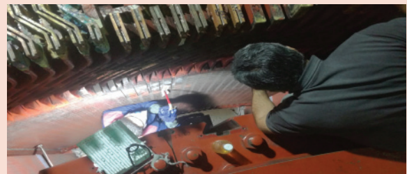
تعمیرات بر روی واحد ۴ نیروگاه کارون ۳
