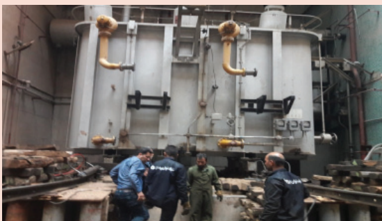
عملیات جابجایی ترانس قدرت واحد ۲ با ترانس قدرت واحد ۴ نیروگاه دز
